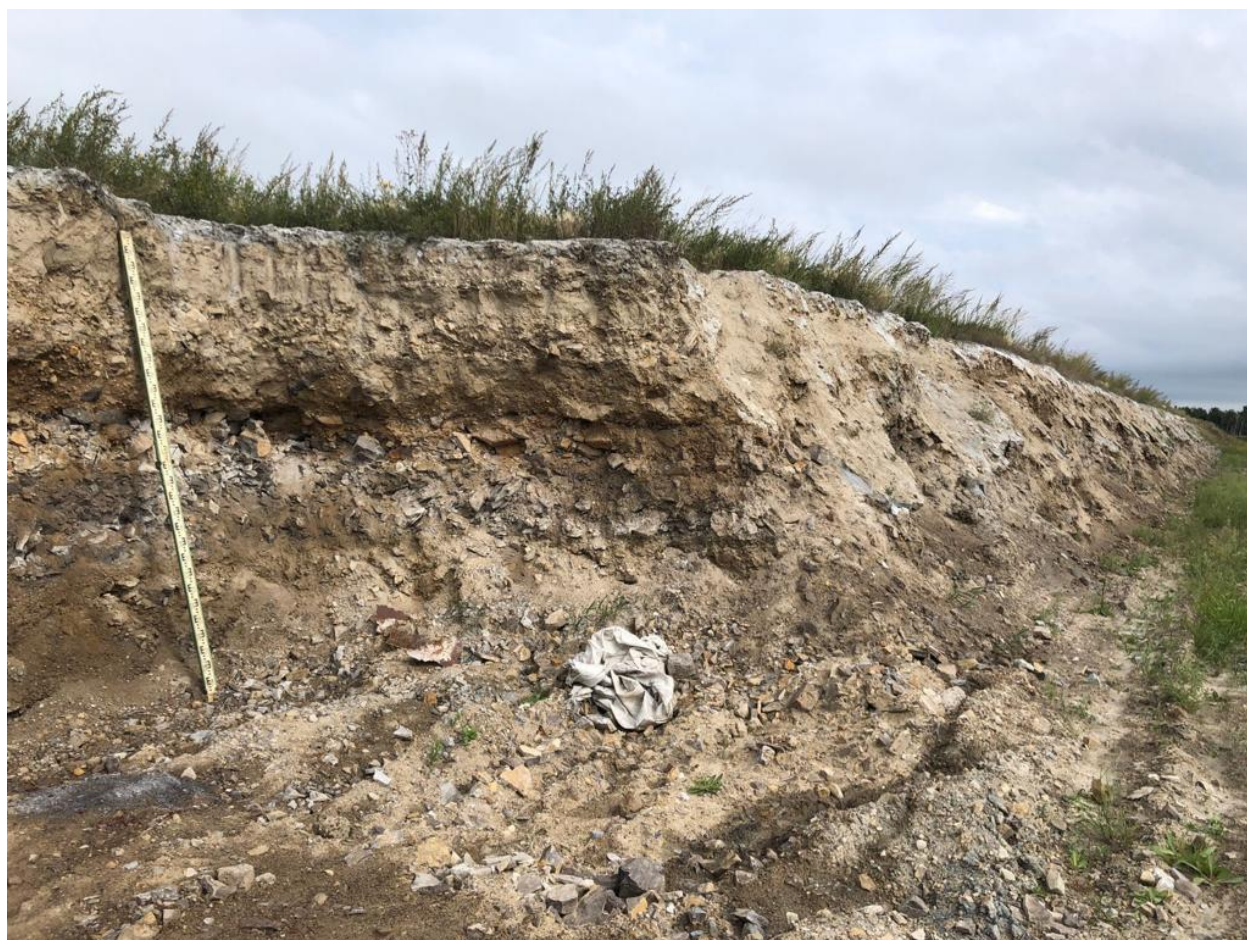
Рисунок 1.3.3. Состояние дамб шламонакопителя
