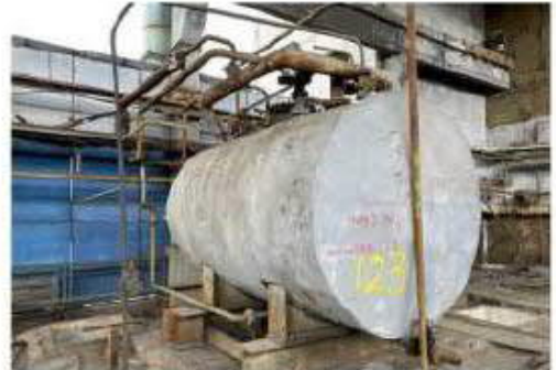
Общий вид здания 94, 4 этаж
