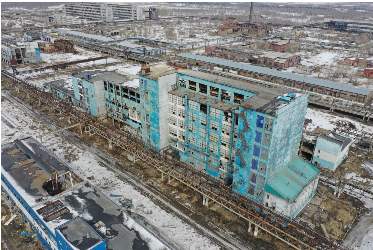
Рисунок 2 – Общий вид здания корпуса 94
