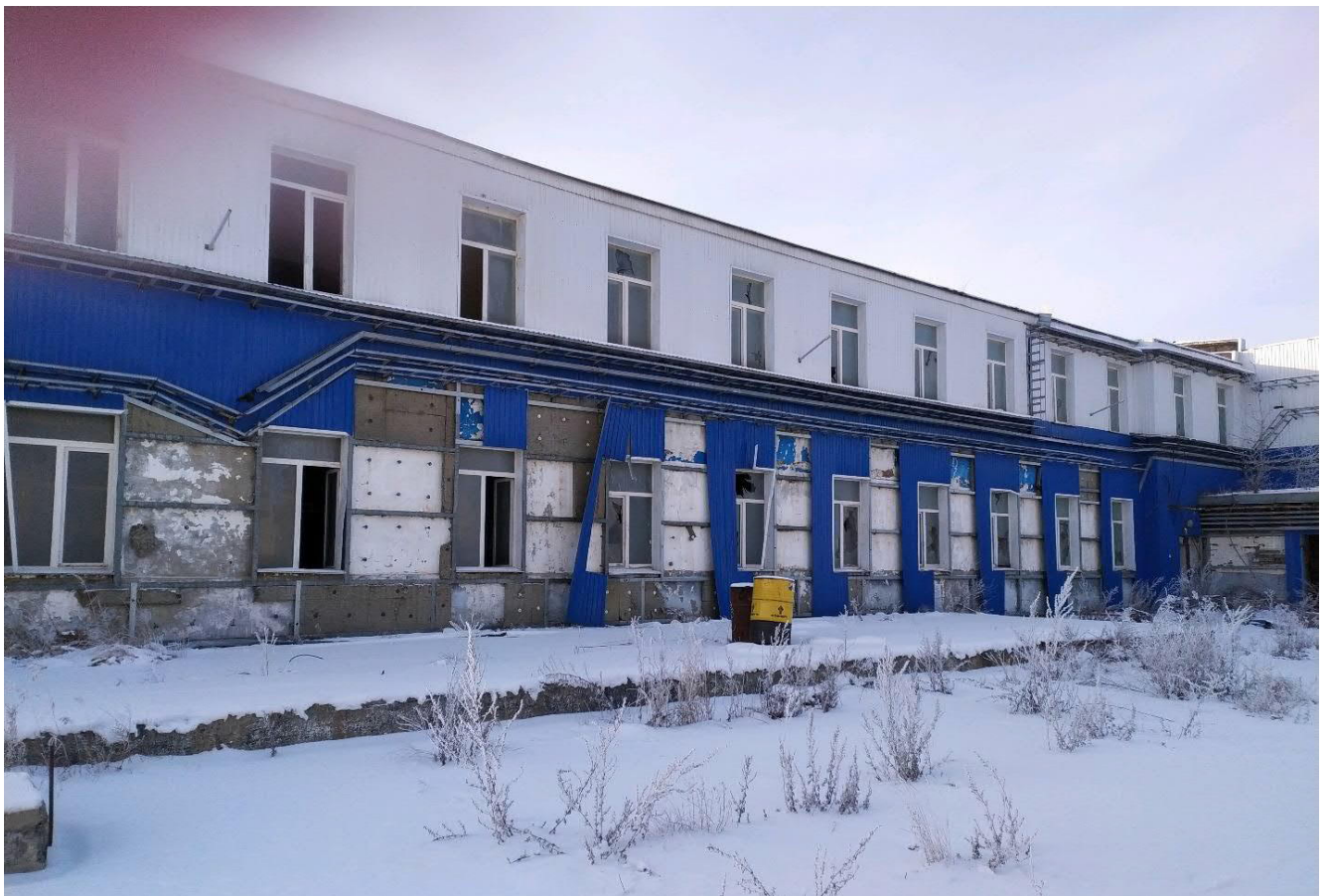
Рисунок 3 – Общий вид здания корпуса 95
