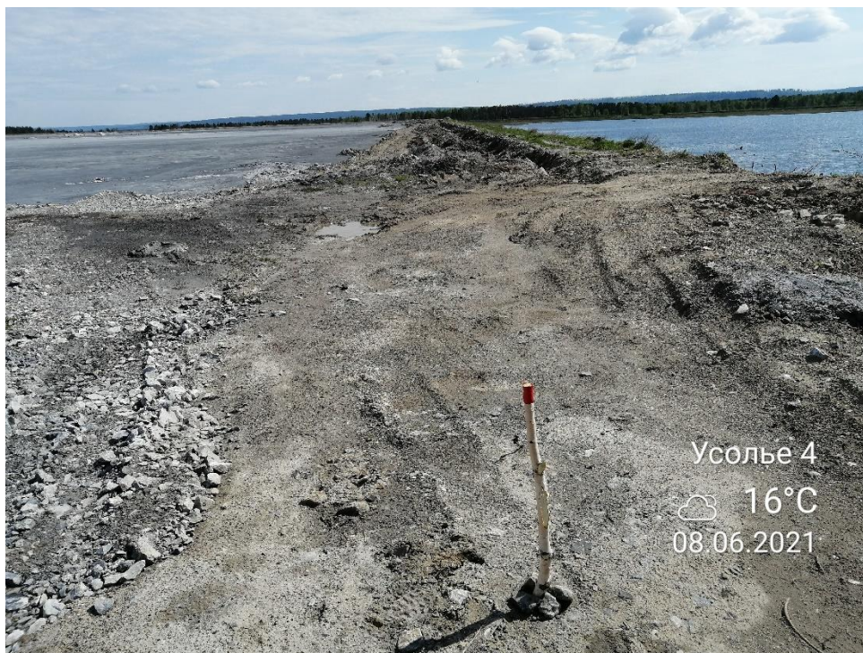
Рисунок 3.3 – Створ 4. Вид на гребень, несанкционированную выемку грунта по гребню, шламонакопители: слева ООО «Усолёхимпром», справа химфармзавода
