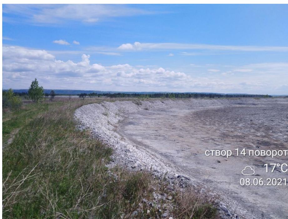
Рисунок 3.20 – Створ 14. Вид на гребень, верховой откос, шламонакопитель на повороте сработавшее поле шламонакопителя в результате аварии (прорыва дамбы), на поле наблюдаются воронки и провалы.
