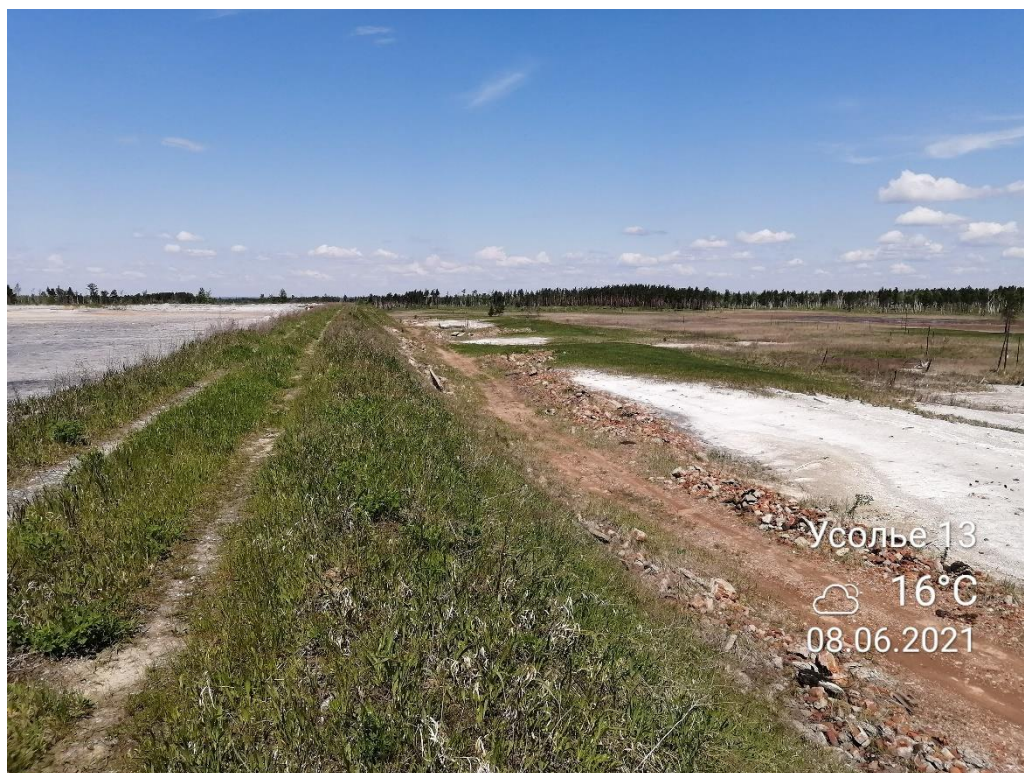
Рисунок 3.15 – Створ 13. Вид на гребень, низовой откос, прилегающую территорию. В НБ наблюдается шламовые «языки» выходы шламов за пределы дамбы в результате прорыва либо фильтрации
