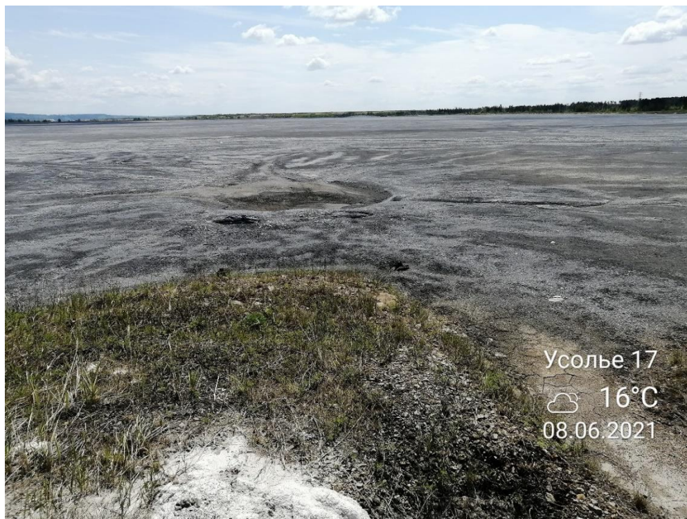
Рисунок 3.31 – Створ 17. Вид на пляж шламонакопителя, воронки и провалы
