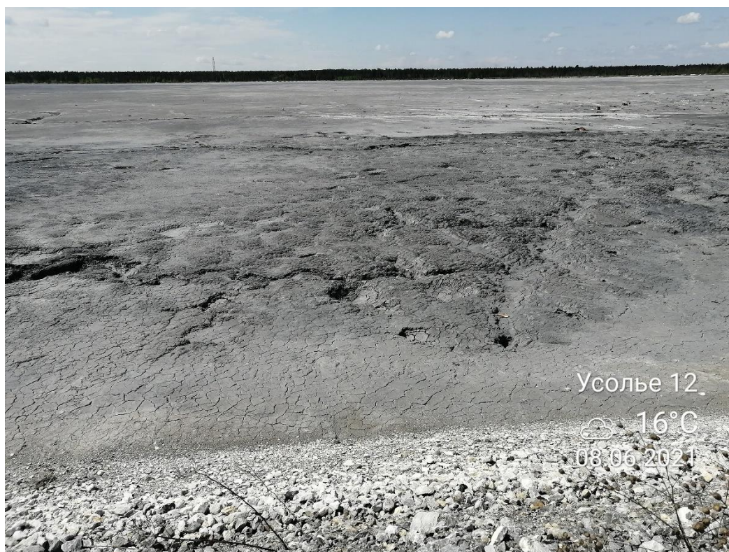
Рисунок 3.14 – Створ 12. Вид на шламовое поле со следами воронок и провалов
