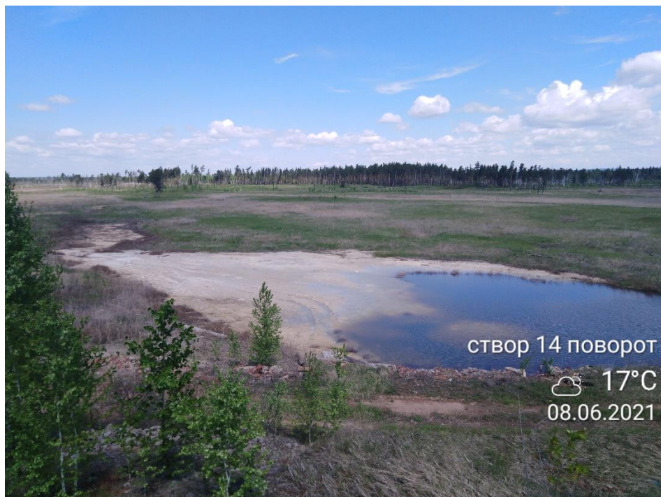
Рисунок 3.21 – Створ 14. Вид 1 с гребня на прилегающую территорию – фильтрационные проявления.
