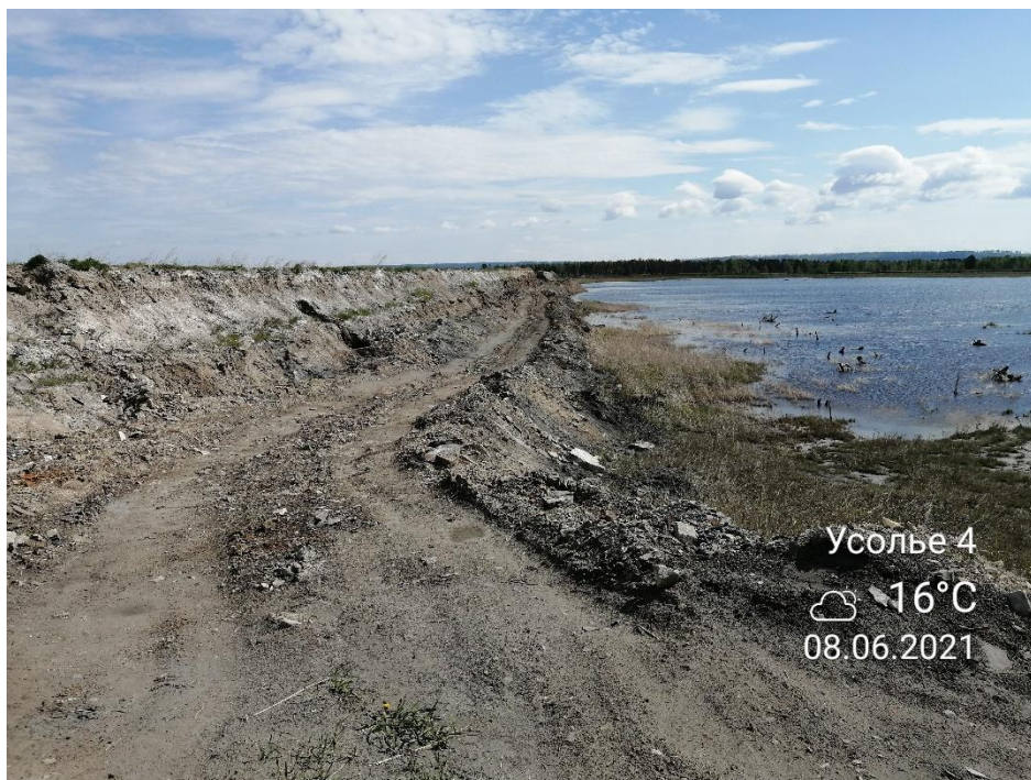
Рисунок 3.5 – Створ 4. Вид на откос гребня со стороны шламонакопителя химфармзавода (произведены несанкционированные земляные работы)
