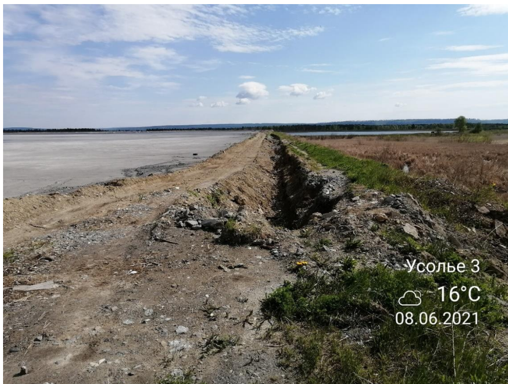
Рисунок 3.45 – Створ 3. Вид на гребень, несанкционированную выемку грунта по гребню
