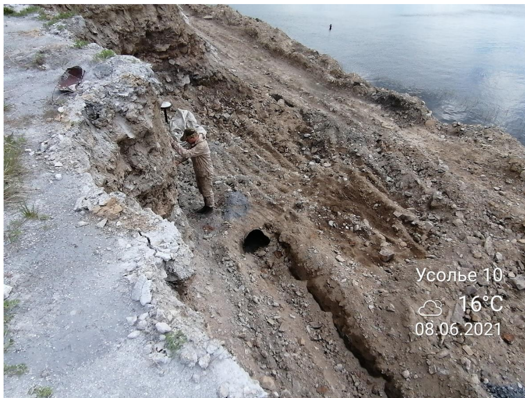
Рисунок 3.7 – Створ 10. Вид на откос со стороны шламонакопителя химфармзавода, несанкционированную выемку грунта
