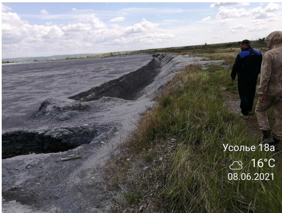
Рисунок 3.35 – Створ 18. Вид на гребень, верховой откос и пляж шламонакопителя, несанкционированная выемка
