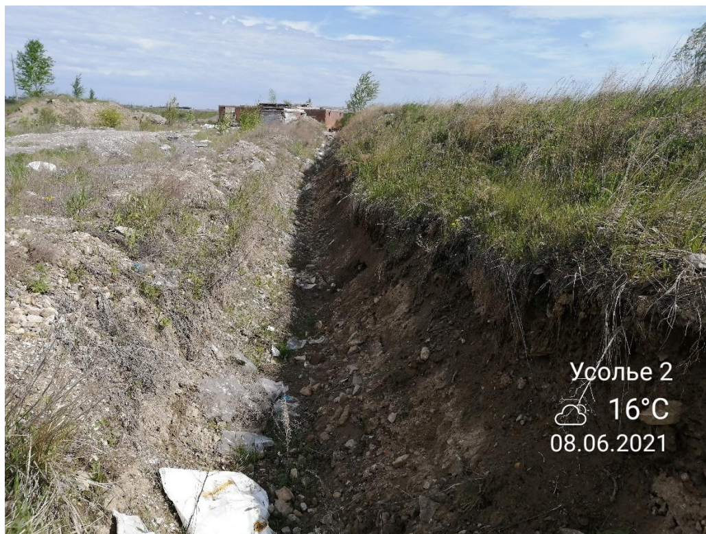
Рисунок 3.42 – Створ 2. Несанкционированная выемка грунта (канавы) вдоль низового откоса, в сторону насосной станции
