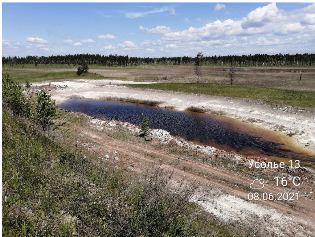
Рисунок 3.19 – Створ 14. Вид с гребня на низовой откос, прилегающую территорию с северо-западной стороны, шламовый «язык» прорыва и фильтрационный выхода
