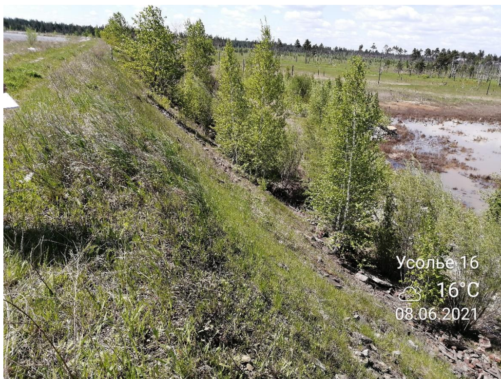
Рисунок 3.26 – Створ 16. Вид с гребня на низовой откос, фильтрационные проявления в виде луж в НБ
