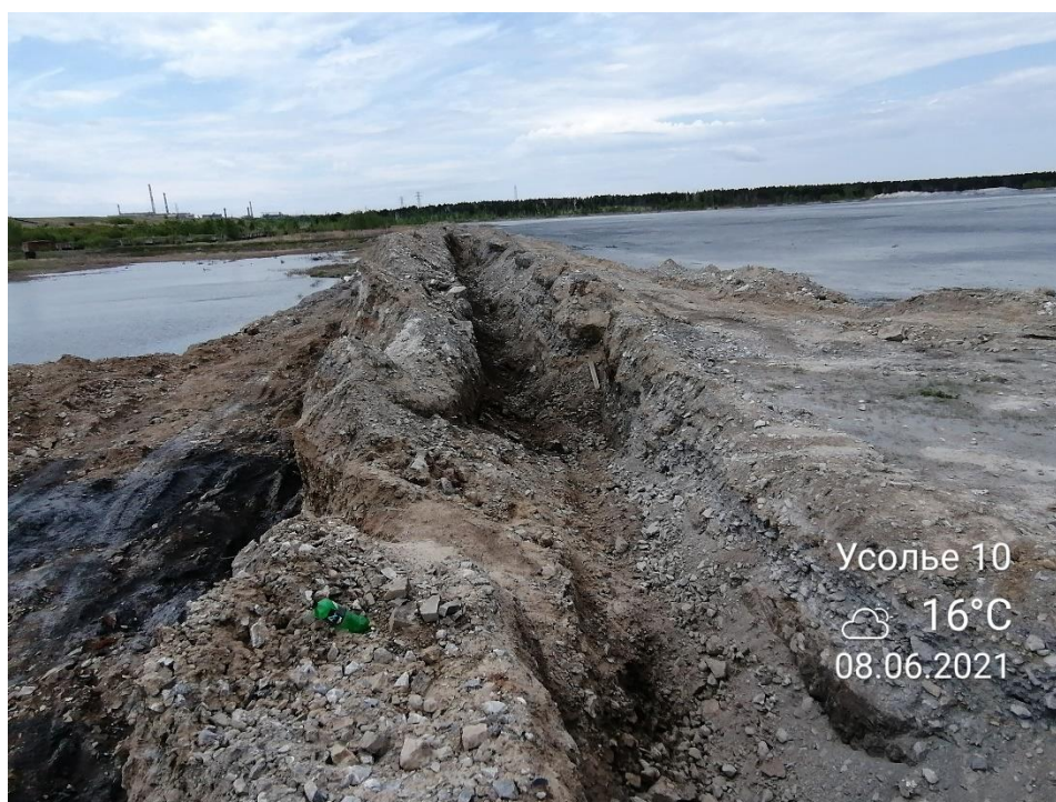
Рисунок 3.6 – Створ 10. Вид на гребень, несанкционированную выемку грунта по гребню, шламонакопители: справа ООО «Усолъехимпром», слева химфармзавода
