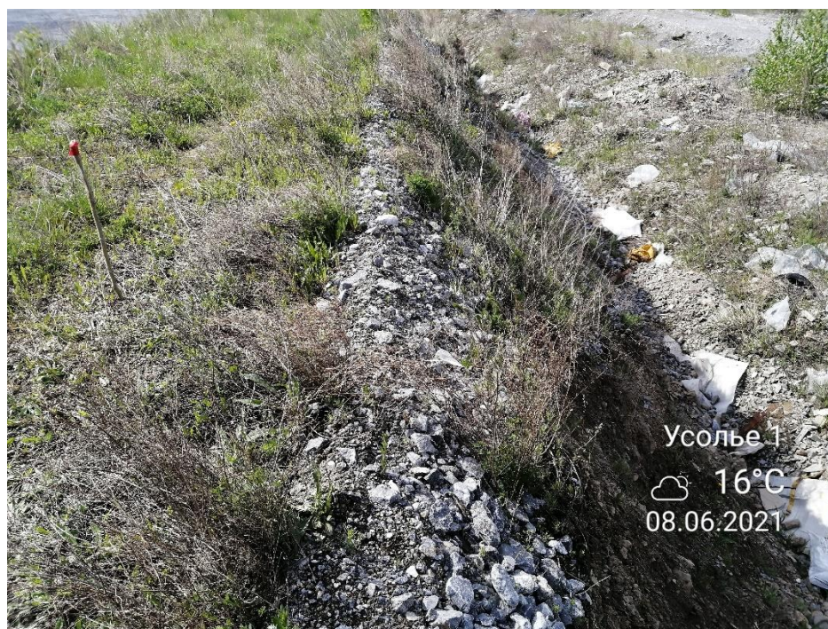
Рисунок 3.40 – Створ 1. Вид на гребень, низовой откос, продольные трещины отрыва по откосу.
