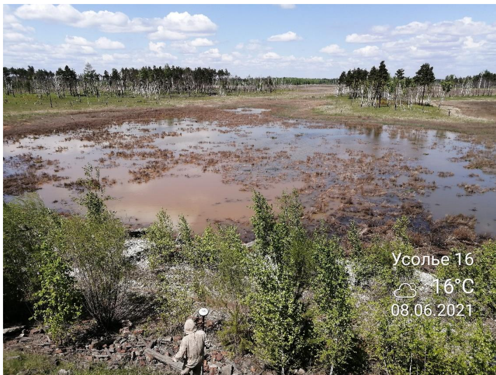
Рисунок 3.27 – Створ 16. Вид с гребня на прилегающую территорию фильтрационные проявления в виде луж в НБ
