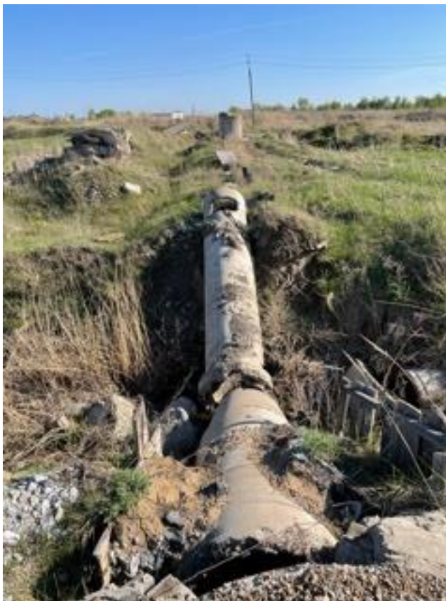
Рисунок 3.5. Рекогносцировочное обследование коммуникаций. Коллектор №2 органически загрязнённых стоков
