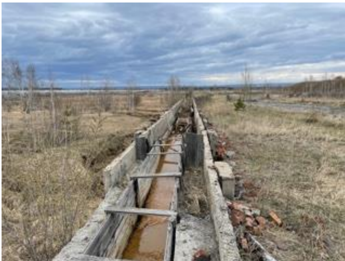
Рисунок 3.8. Рекогносцировочное обследование коммуникаций. Промливнёвый коллектор №2 до р.Ангара
