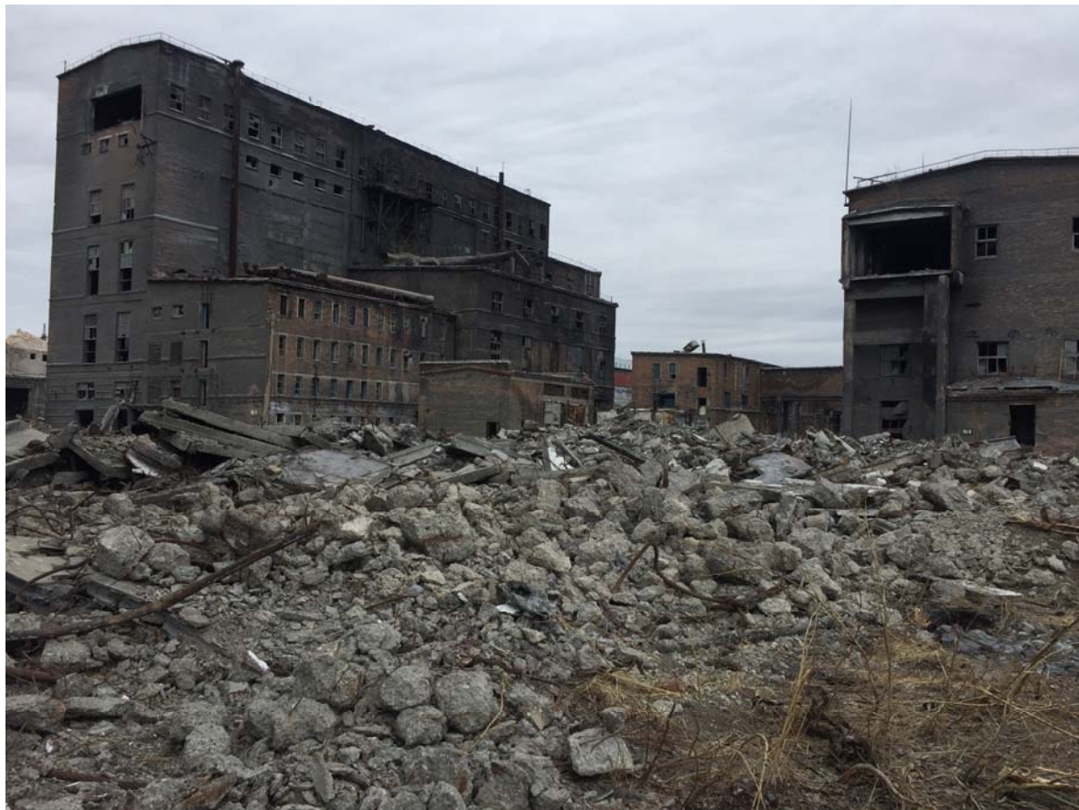
Рисунок 5.1 – Территория завода ООО «Усольехимпром», карбидное производство
