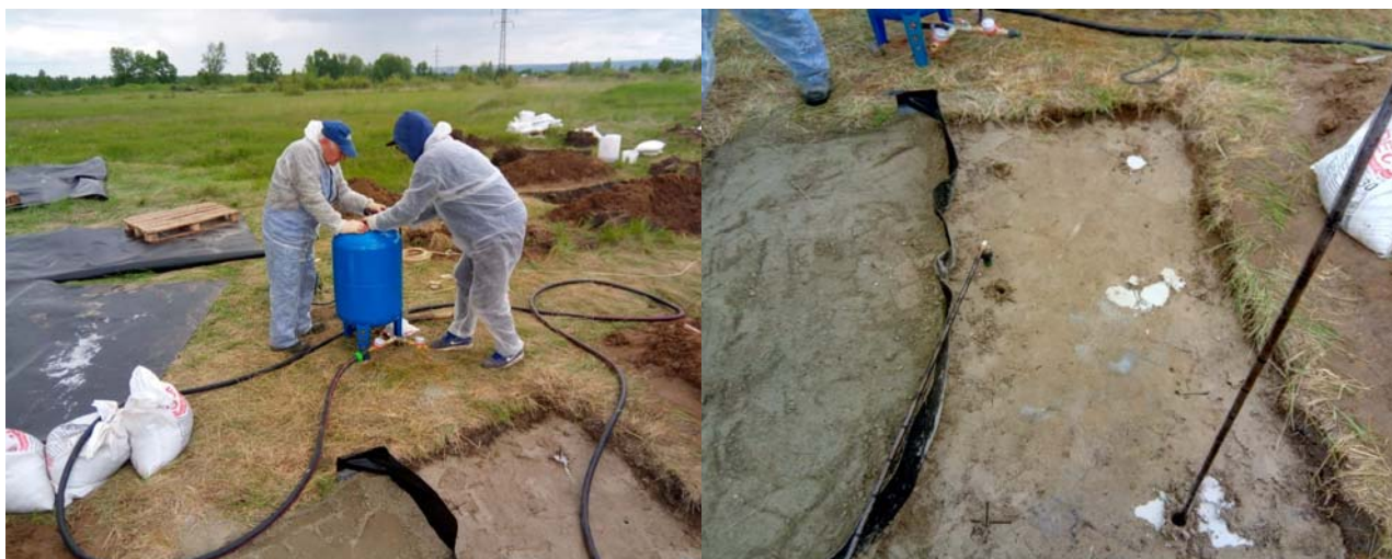
фото 2 Выполнение инъекционных работ на опытном участке
