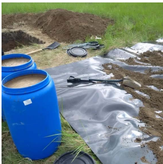
фото 4 Процесс подготовки песчано-гелевого материала высокой проницаемости
