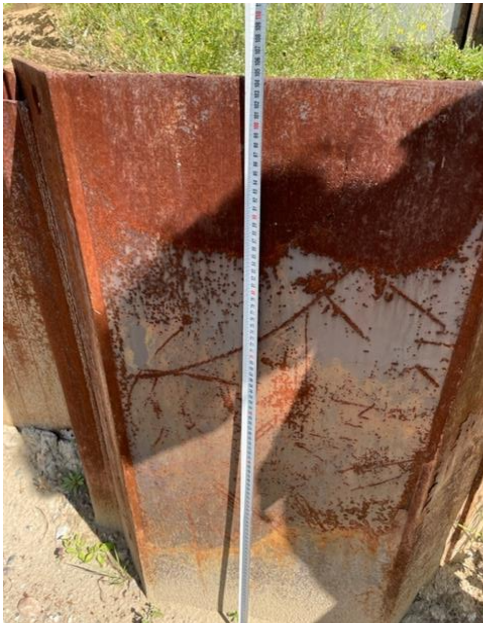
Рисунки 8...12. Сооружение Водозабор «Ангара». Шпунтовое ограждение.
