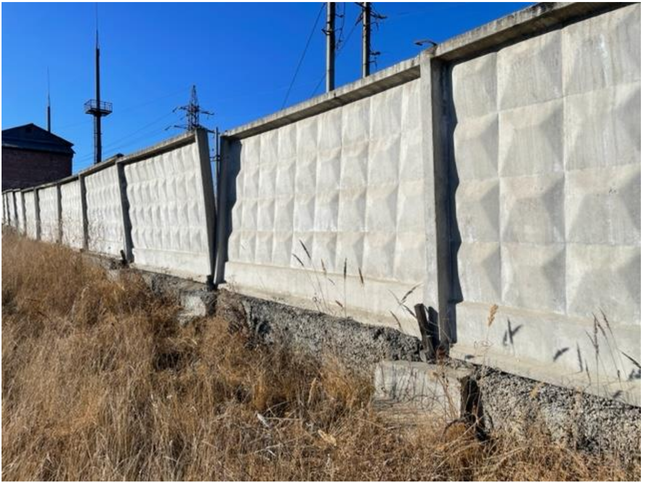
Рисунок 13. Заборное ограждение общий вид
