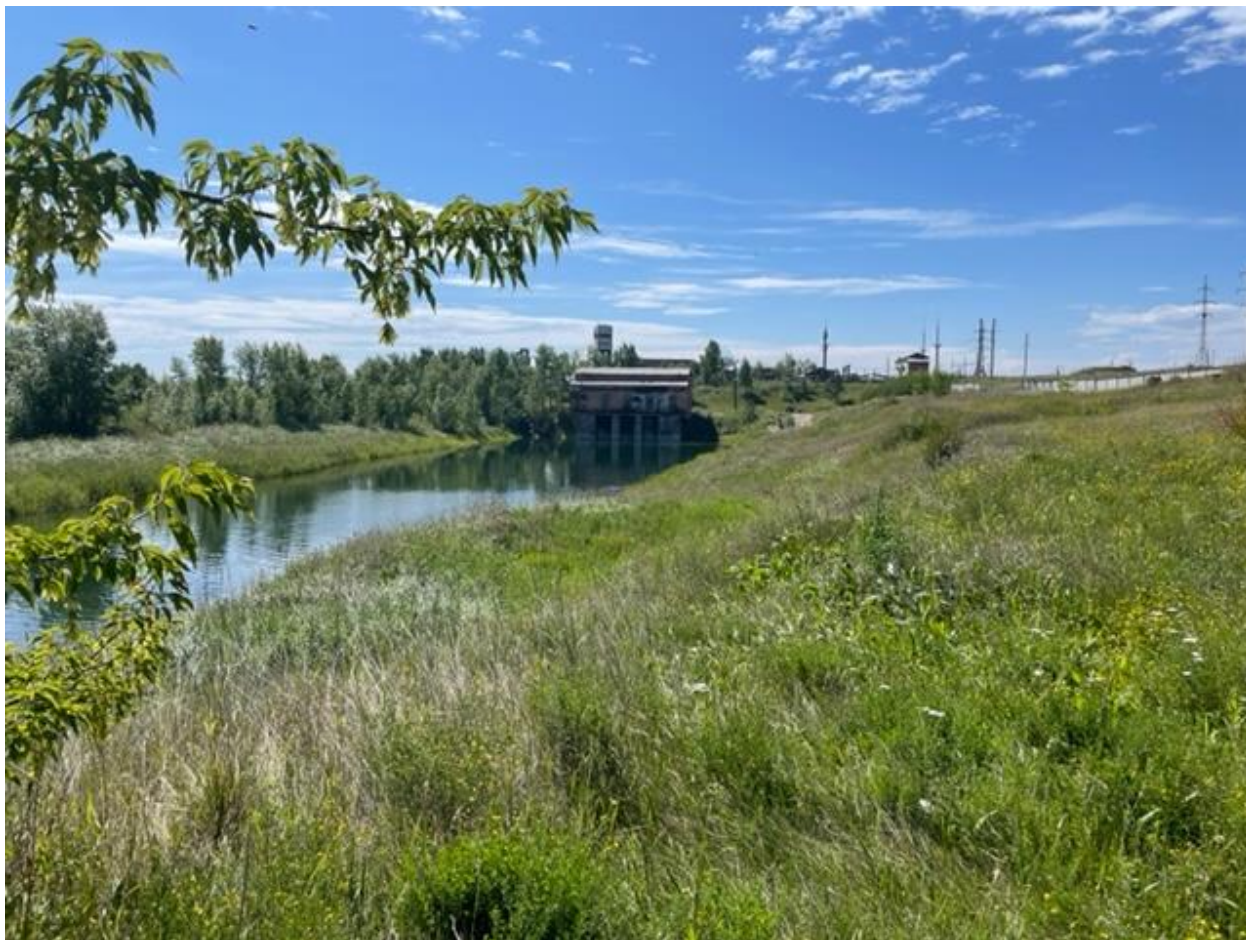
Рисунок 1. Сооружение Водозабор «Ангара» общий вид.
