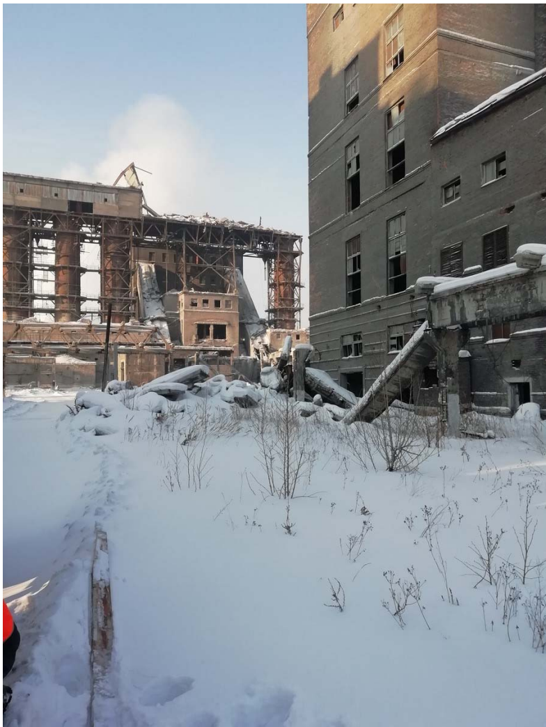
Фото 3.3 – разрушенные здания на площадке УсольеХимпром
