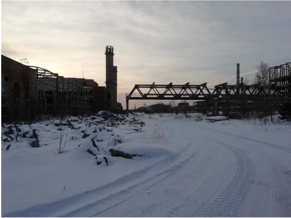
Фото 3.2 – демонтаж эстакад на площадке УсольеХимпрома
