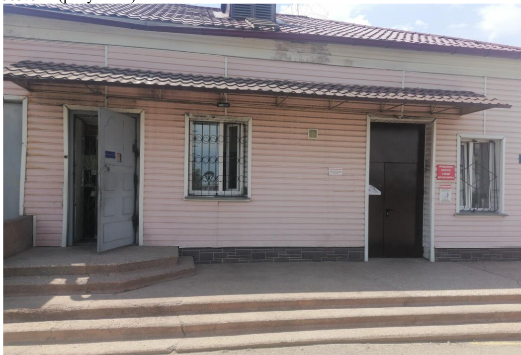
Рисунок 1 – Фото нежилое здание (проходная)
