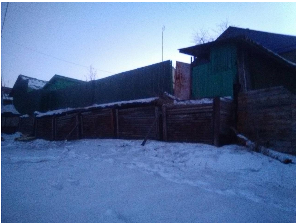
Рис. 2, 3,4. Подпорная стена земельного участка с кадастровым номером 38:31:000040:29.
