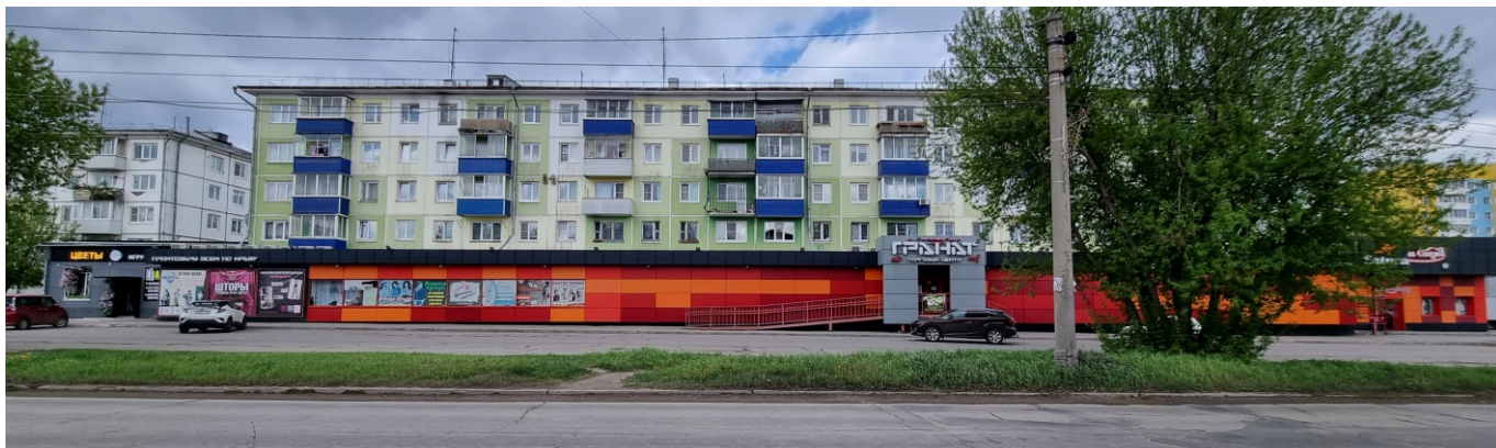
Рис.1 Общий вид фасада с южной стороны
