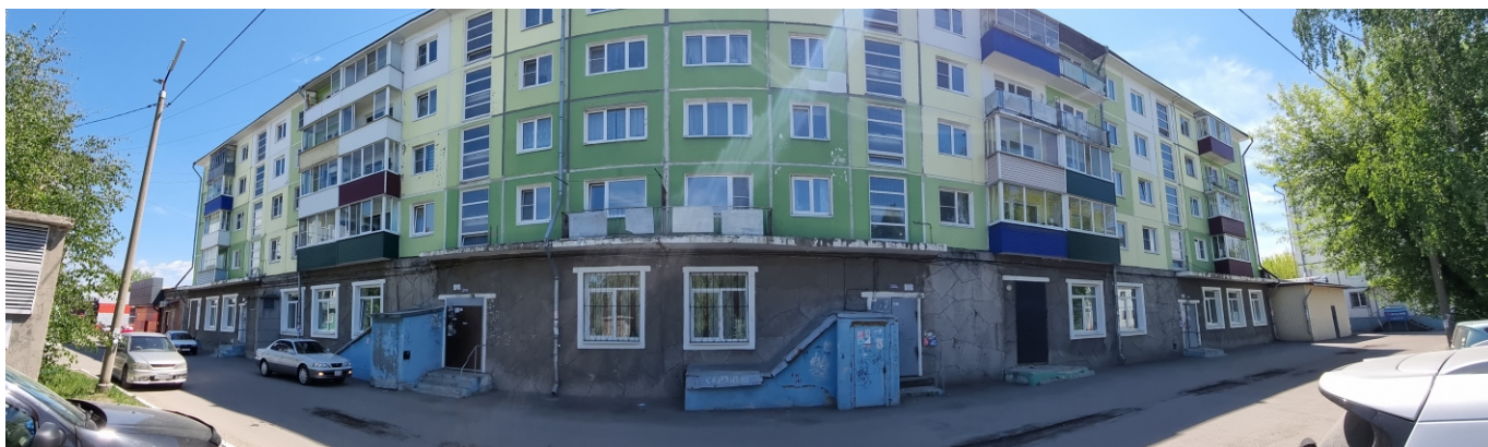
Рис.2 Общий вид фасада с северной стороны
