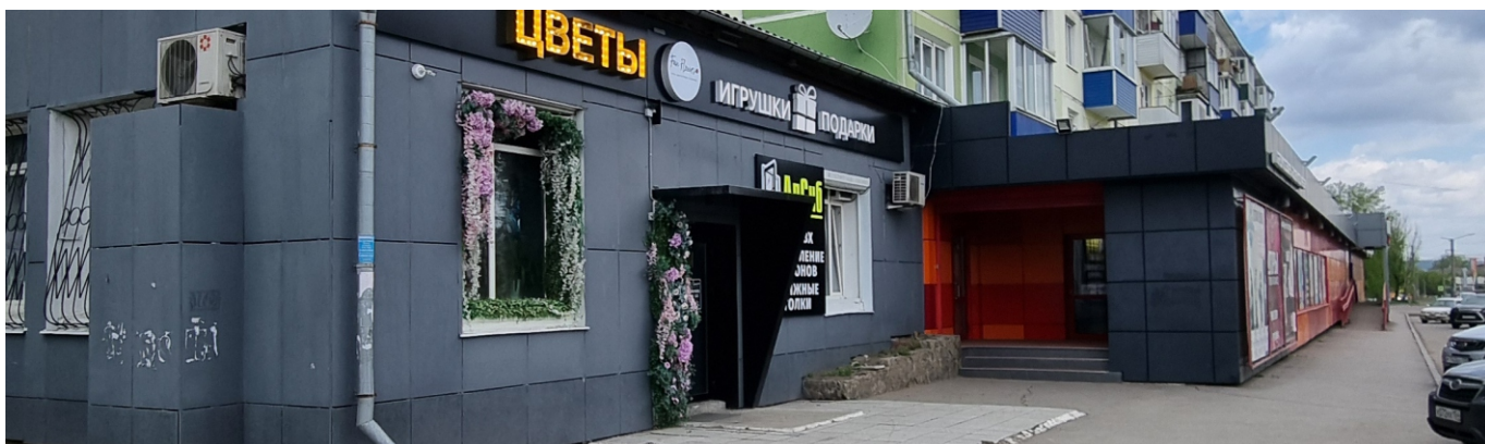
Рис.4 Вид фасада с западной стороны
