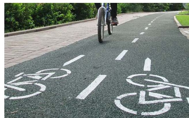
Мелкозернистый асфальтобетон Велодорожка
