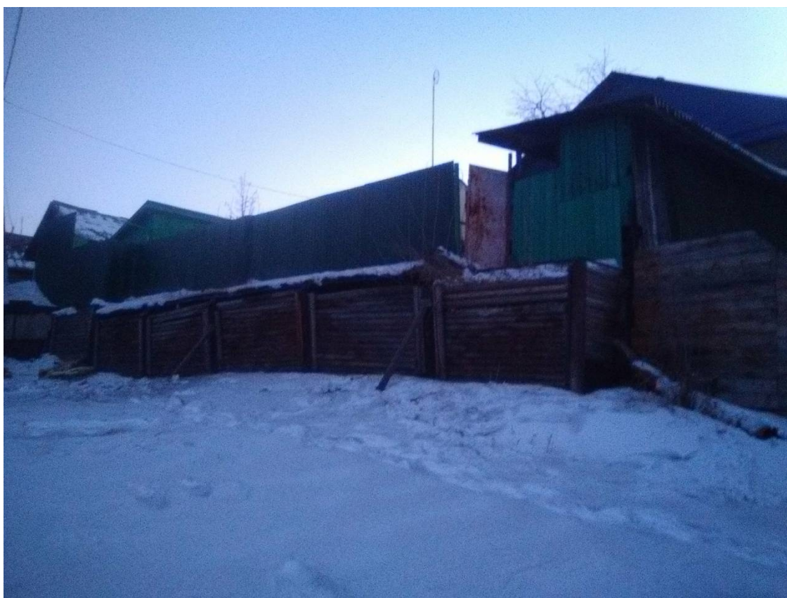
Рис. 2, 3,4. Подпорная стена земельного участка с кадастровым номером 38:31:000040:29.
